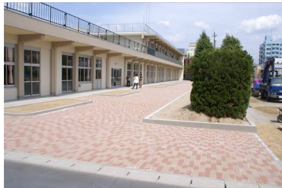
きれいに敷設されたインターロッキング ~南校舎前~ 舗装の上は0.3~0.5 \mu\text{sv/h}
