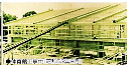
●体育館工事中(昭和53年9月)
