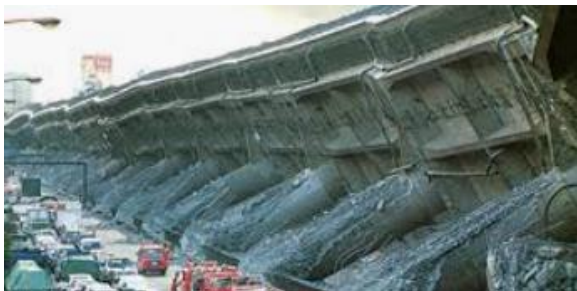
＜地震で倒れた高速道路＞
