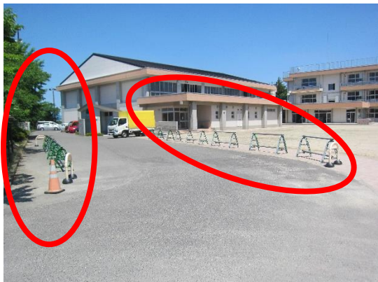
歩車道分離の様子
