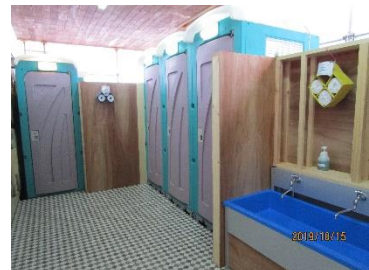
仮設水洗トイレと手洗い場
