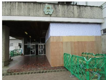
児童昇降口右側は仮設トイレ
