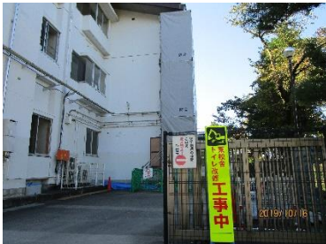
東校舎トイレ改修工事外観
