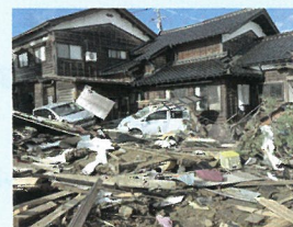
能登半島災害支援のために いしかわんすすしりあ (石川県珠洲市の被災の様子)
