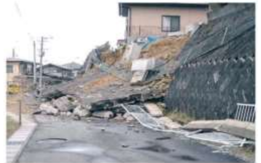
【富田町の被害の様子】
