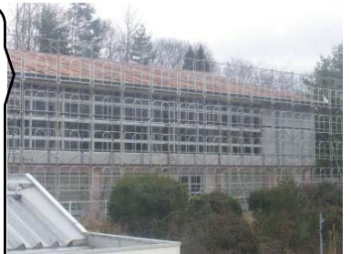
【体育館屋根改修工事】 ※雨漏り防止等
