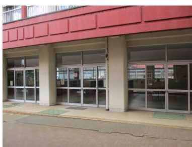
西昇降口（通常施錠）
