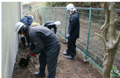
校舎西側、物置とフェンスの間の表土除去をしました。
