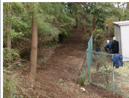
校舎西側フェンスの外の部分は、積もった堆積物を除去しました。
