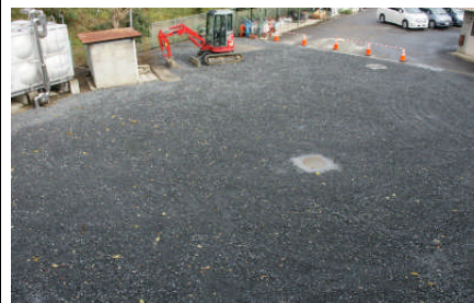
北校舎、2年廊下の外側の砂利の部分を取り除き、新しく砂利を敷き詰めました。
