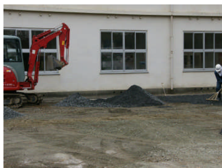
北校舎、2年廊下の外側の砂利の部分を取り除き、新しく砂利を敷き詰めました。
