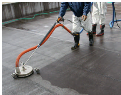
北校舎部分の洗浄の様子です。吸引式の高圧洗浄機での作業でした。洗浄後は色が変わっているのが見て取れます。
