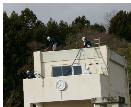
西側部分の時計台にも上って、屋上部分の洗浄をしました。
