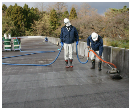
北校舎部分の洗浄の様子です。吸引式の高圧洗浄機での作業でした。洗浄後は色が変わっているのが見て取れます。
