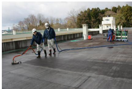
北校舎部分の洗浄の様子です。吸引式の高圧洗浄機での作業でした。洗浄後は色が変わっているのが見て取れます。
