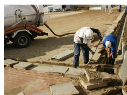
校庭にある側溝は、すべて、泥を除去し、高圧水洗浄をしました。
