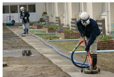
コンクリート部分は、全て「吸引式高圧洗浄機」を使い、洗浄・吸引をしました。
