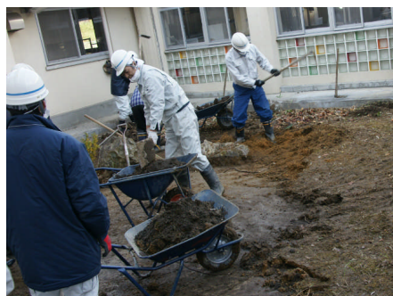
中庭(給食室と1年教室の間の庭)の表土除去・コンクリート部分の除染・側溝掃除
