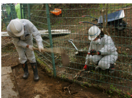
フェンスの際の表土除去
