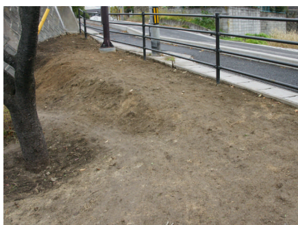
体育館東北部分の表土除去
