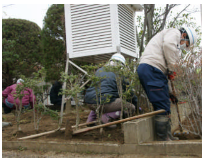
中庭(給食室と1年教室の間の庭)の表土除去・コンクリート部分の除染・側溝掃除
