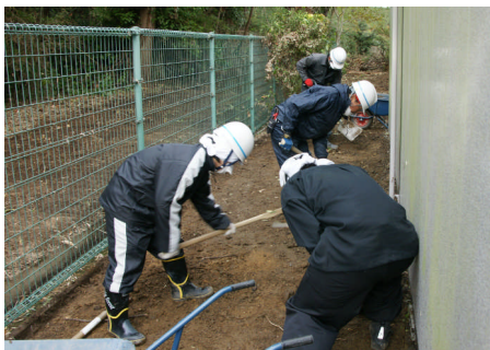
校舎西側部分の表土除去
