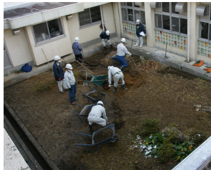
中庭(給食室と1年教室の間の庭)の表土除去・コンクリート部分の除染・側溝掃除
