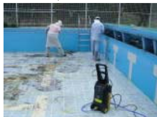
【高圧洗浄機で除染】
