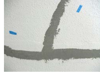
【エポキシ系固形樹脂の塗布】
