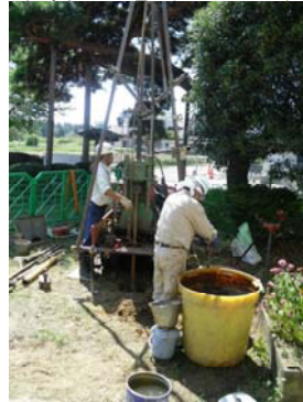
【地下の地盤の状況を掘削して調査】
