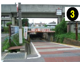
3 ほ道がなく雨のたまるずい道
