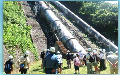
写真：秋元発電所
