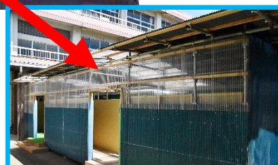
中庭にある仮設トイレは水洗で、屋根・壁がついています
