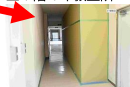
▲職員室側から見た様子 トイレに囲いを作り作業しているため、通路が狭くなっています。音の出る工事から始めています。
